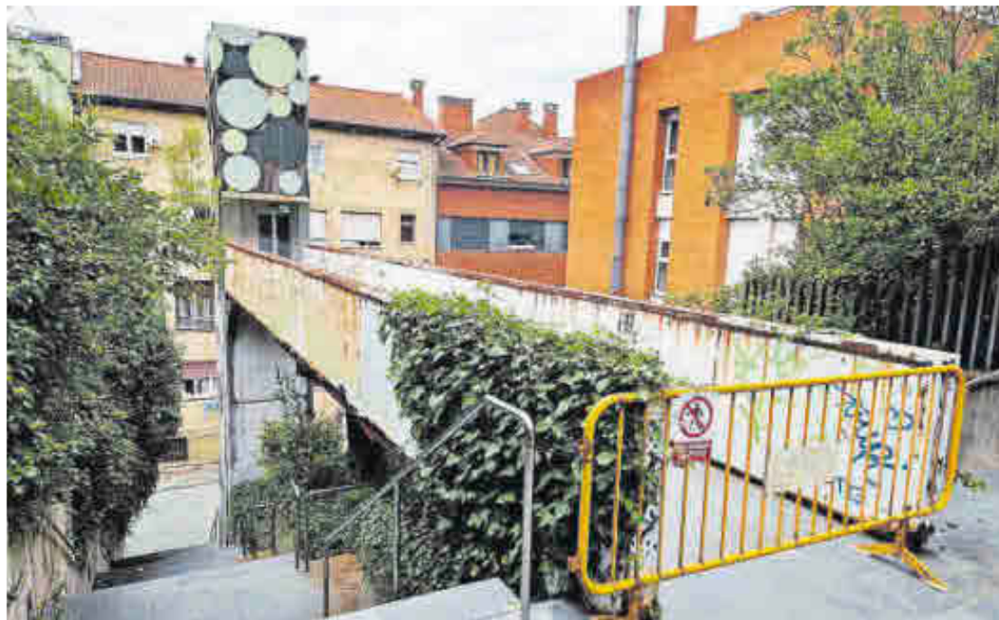
Aspecto que presentaba ayer la pasarela de los Jardines de la Rodriga.
